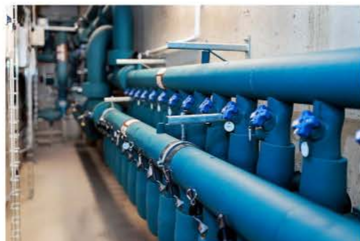
Tillopps- och returledningar för borrhålen i energicentralen i Fyrtornet.
