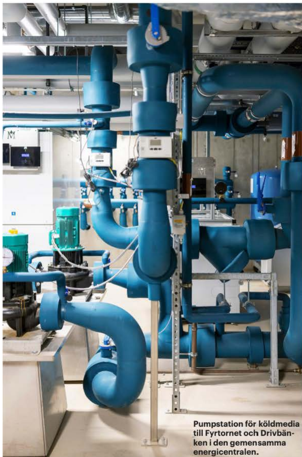
Tillopps- och returledningar för borrhålen i energicentralen i Fyrtornet.
