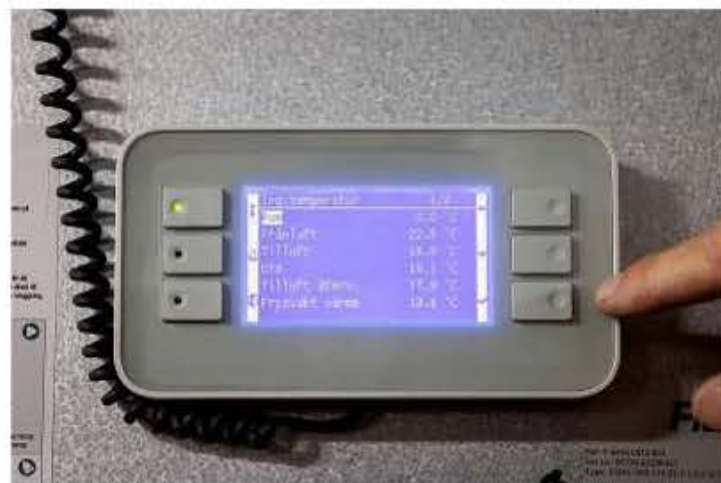
Handdosa för lokal drift av ett av de nya ventilationsaggregaten. Den används dock inte i normal drift utan samtliga parametrar nås i det överordnade styrsystemet via modbus.
