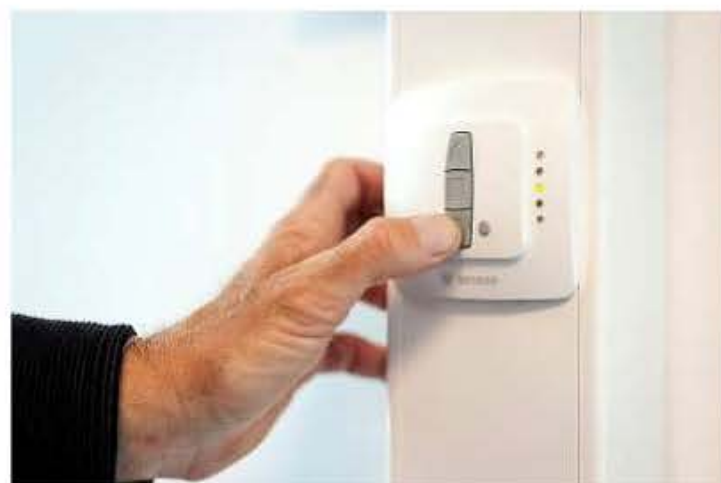
Panel för manuell styrning av invändiga rullgardiner för solskydd.
