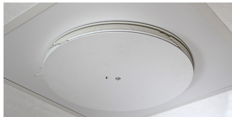
Ett aktivt taktilluftsdon monterat med undertaksplåt UTD i undertakets bärverk.
